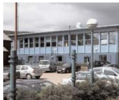
I denne bygning i hjertet af Færøernes hovedstad holder MRCC-Torshavn og Torshavn Radio til. En sammenlægning har længe været undervejs, men foreløbig opererer centralerne uafhængigt af hinanden.
